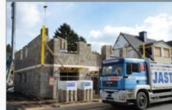
Mit den hochwärmedämmenden Steinen aus dem JASTO Plan Therm System erfüllen wir die Anforderungen der EnEV in monolithischer Bauweise.
