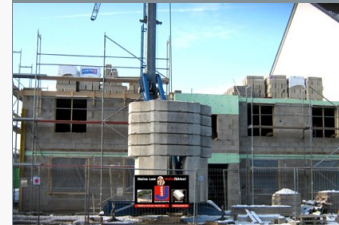
JASTO-Steine aus Leichtbeton mit geringstem Bedarf an nicht-erneuerbarer Primärenergie.
