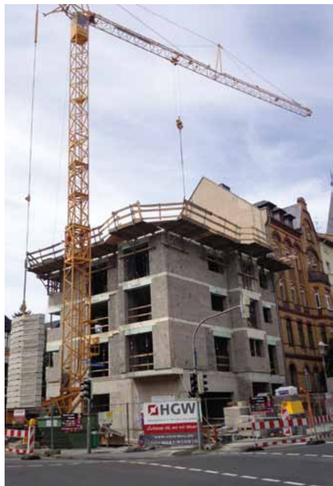
Rascher Baufortschritt: Dank des rationellen Umgangs mit Mörtel und des stimmigen Mauerstein-Systems von Jasto konnte der Rohbau zügig erstellt werden. Ergänzungssteine sorgten für problemloses Arbeiten an Anschlußstellen. Fotos (4): BL/ J-ARCHIV
