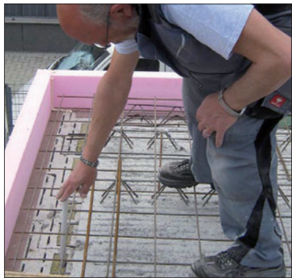
Leerrohr bis zum Bohrloch durchschieben
