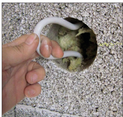
Kabel aus dem Bohrloch ziehen!
