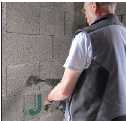
Bohrlöcher für Anschluss z.B. Schalter oder Verteilerdose
