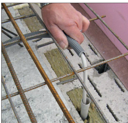
Kabel nachschieben und Leerrohre verbinden!
