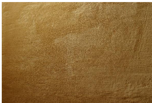
Lehmputz: typische Oberflächenstruktur
