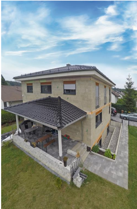
Bild 1: Signifikanter Unterschied: Im Vergleich zu einem Haus mit Ziegelmauerwerk spart ein Einfamilienhaus aus Leichtbeton 21,6 t CO 2 ein.
