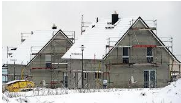
Die Baufirma muss den Bau bei solchen Bedingungen vor der Witterung schützen
