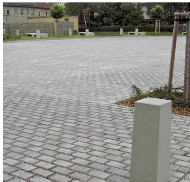
Bild 6: Versickerungsfähige Pflasterdecke mit aufgeweiteten Sickerfugen
