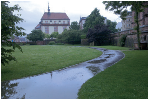
Bild 5: Wassergebundene Wegedecke unter dem Einfluss von Starkregen
