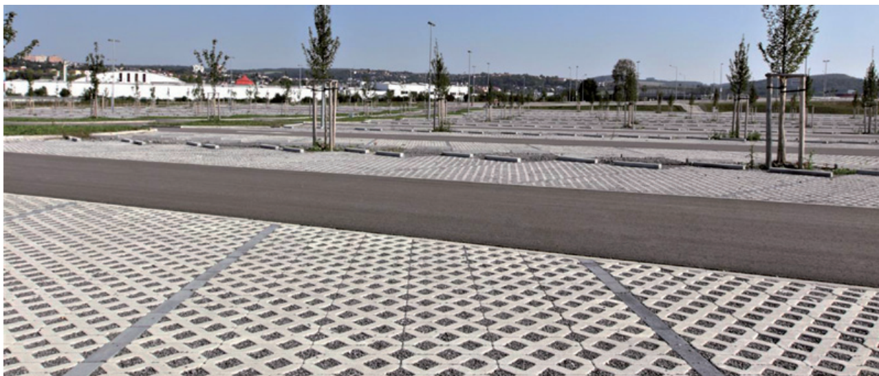
Bild 7: Versickerungsfähiger Plattenbelag mit Sickeröffnungen in Form von durchgehenden Löchern
