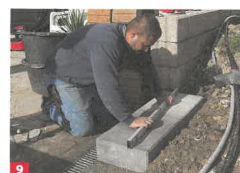
9 ... kann. Das erhöht die Rutschsicherheit vor allem bei überfrierender Nässe und verhindert, dass Wasser in die Treppe eindringt.
