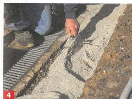
4 Das lagenweise Aufbringen von Mörtel und Wasser gelingt mit Trocken-Fertigbeton.
