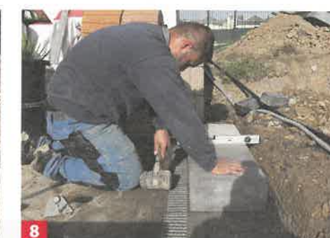
8 Die Stufe im Beton ausrichten. Dabei eine leichte Neigung von 1 cm nach vorne beachten, damit Regenwasser leicht abfließen ...
