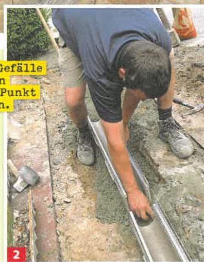
2 Nun die Rinnenkörper zusammenstecken; Fließrichtungspfeile beachten!
