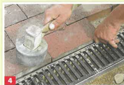
4 Hat der Beton abge bunden, Sand auffüllen und Pflastersteine legen.
