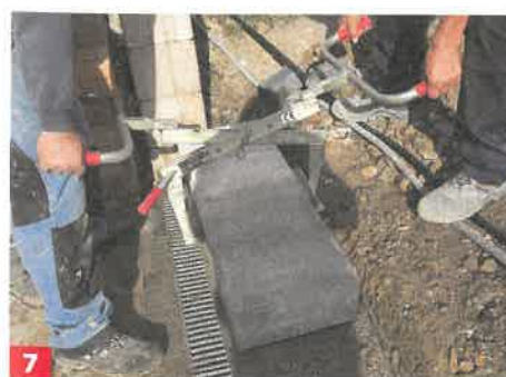
7 Solche Hilfswerkzeuge ggf. im Werkzeugverleih mieten. Die Stufe kann man so recht leicht in das 20 cm dicke Betonbett setzen.
