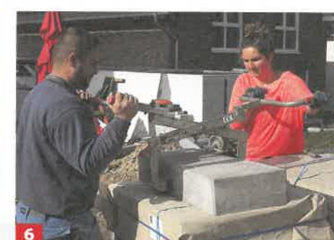
6 Zum Versetzen der schweren Blockstufen empfiehlt sich eine Stufenversetzzange.
