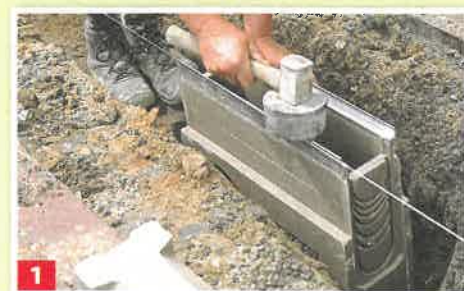
1 Erst den Einlaufkasten am tiefsten Punkt (Ablaufpunkt) ins Betonbett setzen.
