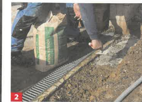
2 Die untersten Blockstufen setzt man in ein 20 cm dickes Betonbett. Füllen Sie entsprechend Kies/Schotter und dann Beton auf.
