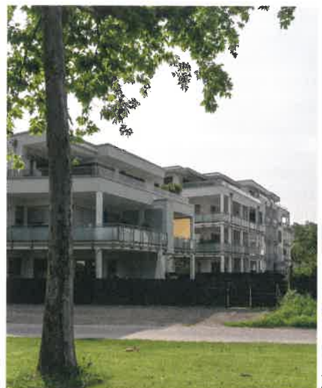
Das gesamte Bauvorhaben orientiert sich an einem möglichst kleinen ökologischen Fußabdruck.
