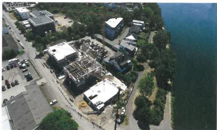
Die Anlage in der Bauphase: Das Gewerbegebiet beginnt auf der gegenüberliegenden Straßenseite.
