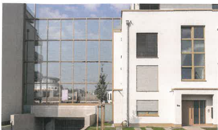
Große Schallschutzwände aus Glas schirmen die Garten- und Balkonflächen auf der Rückseite des Gebäudes vor der Geräuschkentwicklung im Gewerbegebiet ab.
