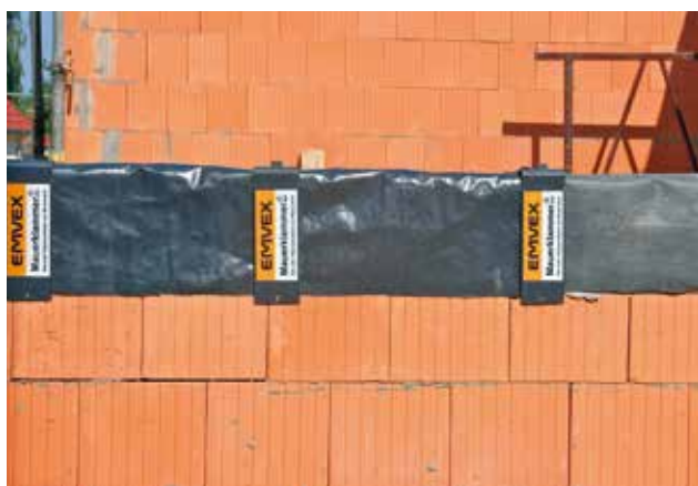
Bild 1: Fachgerecht abgedeckte Ziegelmauerkronen
