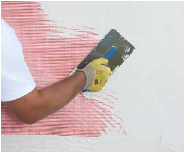
Bild 4: Vollflächiges Einbetten des Armierungsgewebes in einen Armierungsmörtel
