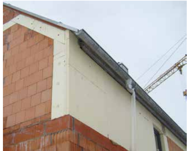
Bild 5: Teilgedämmte Fläche in einem monolithischen Ziegelmauerwerk
