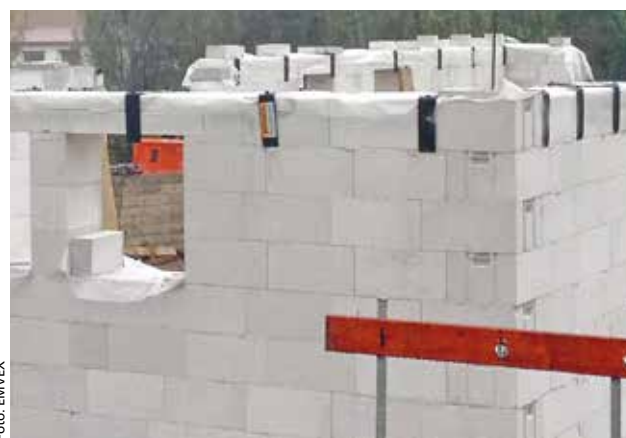
Bild 2: Fachgerecht abgedeckte Porenbetonmauerkronen
