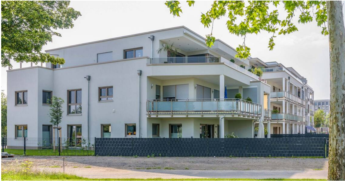
Fotos @ Jasto Baustoffwerke
