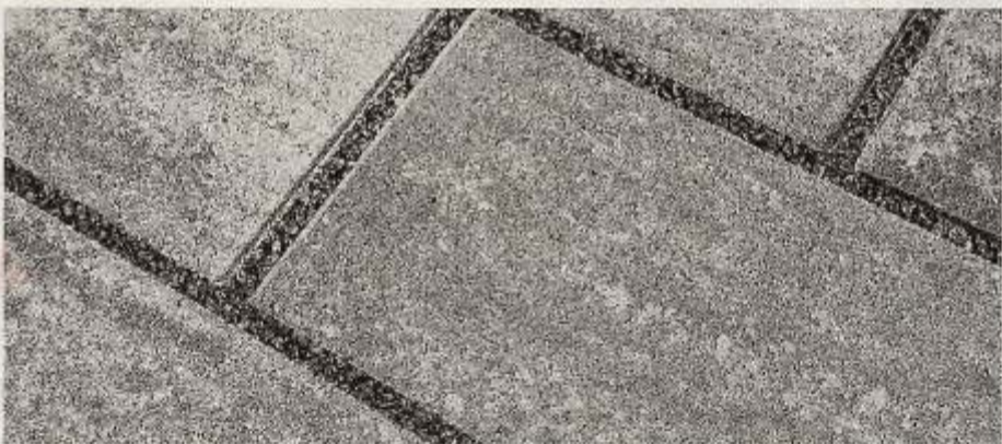
Trendline-Pflaster Aqua in der Farbe Anthrazit-Weiß-nuanciert: Der vergrößerte Fugenabstand erhöht die Versickerungsleistung.
