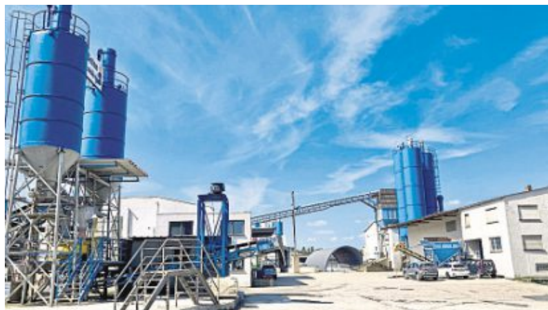
Das Firmengelände in Ochtendung ist inzwischen 300 000 Quadratmeter groß. Jasto ist heute Arbeitgeber für 100 Menschen.
