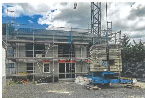
Die Steine wurden in einer Wanddicke von 36,5 cm eingesetzt und kommen ohne zusätzliche Wärmedämmung aus.
