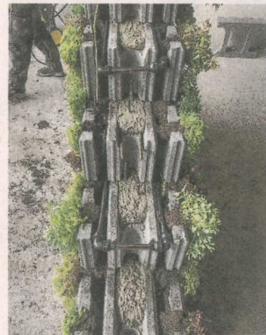
Die innere Kammer des Mauer-systems kann ausbetoniert und armiert werden. Fotos (2): Jasto
