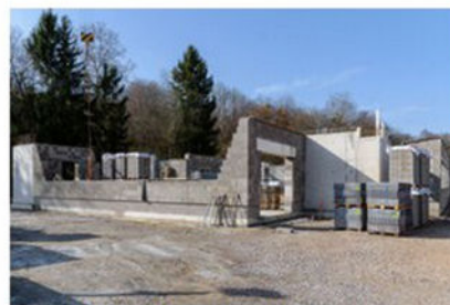
Die neue Kita in Dahlheim setzt auf Außen- und Innenmauerwerk von den Jasto Baustoffwerken. (Bilder: Jasto)
