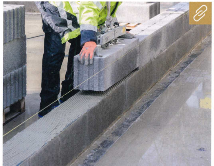
Die 99,7 cm langen Jasto Quadro Lang Phon-Steine – versetzt mithilfe eines Minikrans – trugen zum schnellen Baufortschritt bei.
